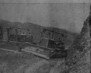
El ingeniero Jiménez Ortiz, trabajando en la construcción de la carretera de San José a Puriscal.
